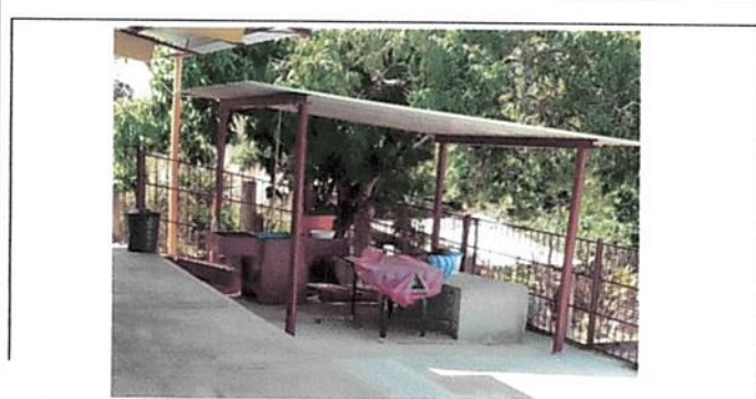
Foto 7: Reconstrucción de Polletón en cocina
