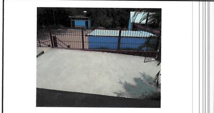
Foto 8 Mejoramiento de torta de concreto (nivelación y alizado)
