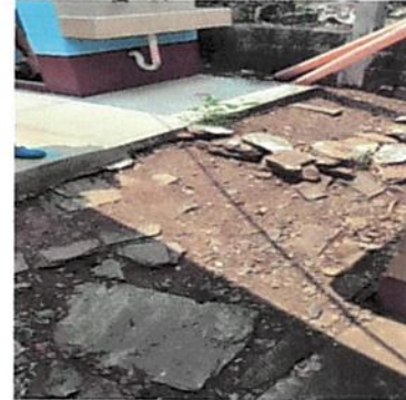
Foto 2: Reconstrucción de torta de concreto 10 cms de espesor en patio del establecimiento.
