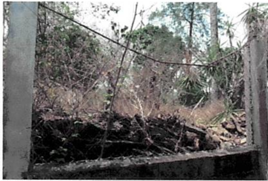
Foto 3: Cambio de malla de 1.50 metros
