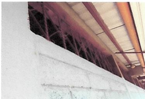
Foto 5: Colocación de ventanas de PVC del establecimiento
