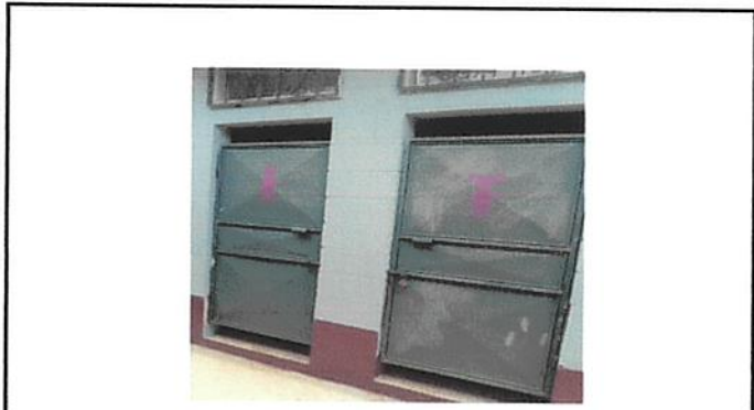
Foto 9: Mantenimiento de puertas de baño y una bodega.
