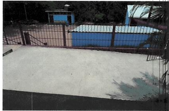
Foto 4: Reemplazo de barandas en el establecimiento.
